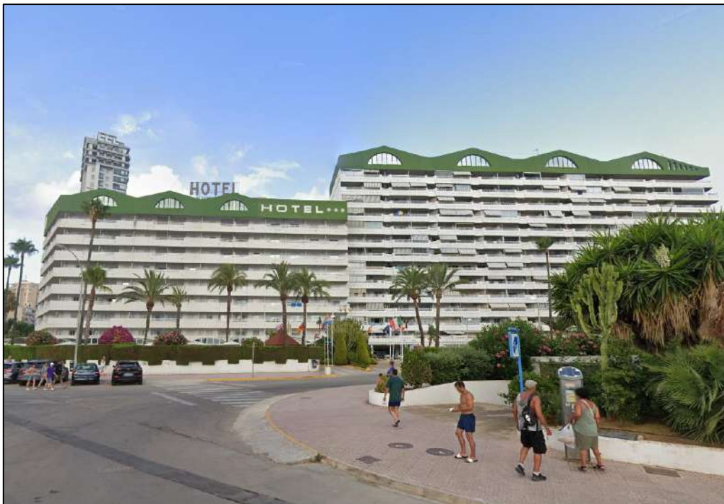
IMAGEN DE “EDIFICACIÓN APANTALLADA” EN CALP
